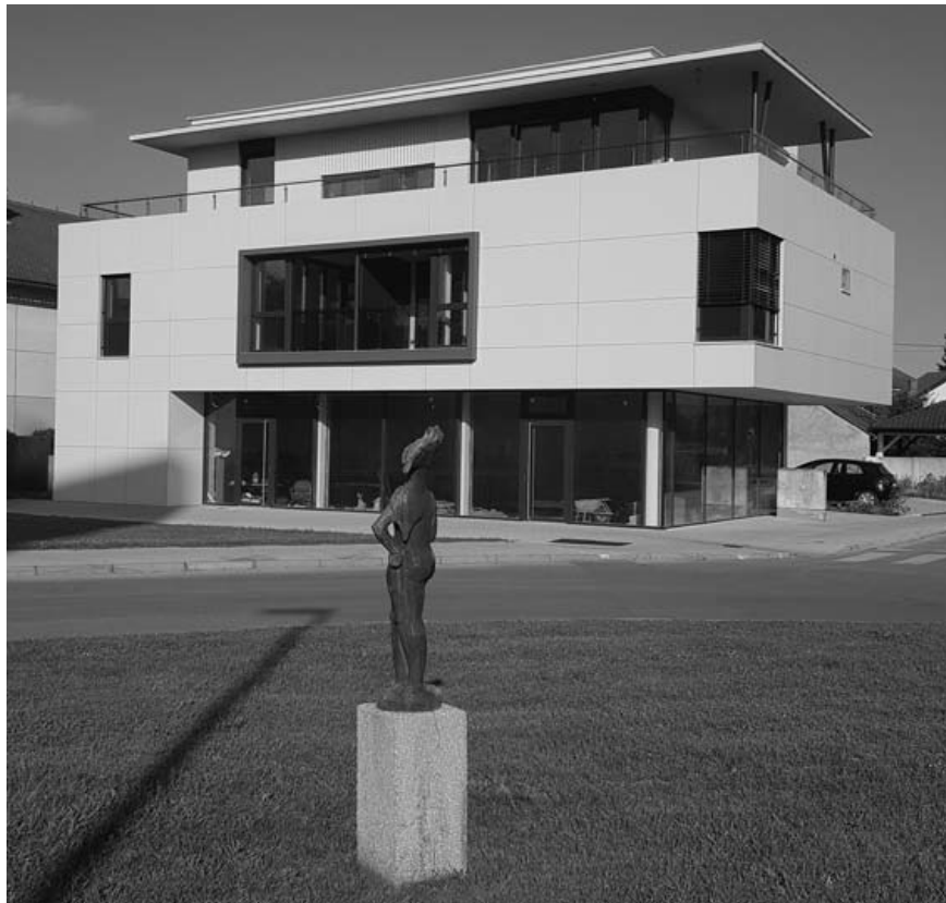
Stambeno-poslovna zgrada Izgradnja, Čakovec
