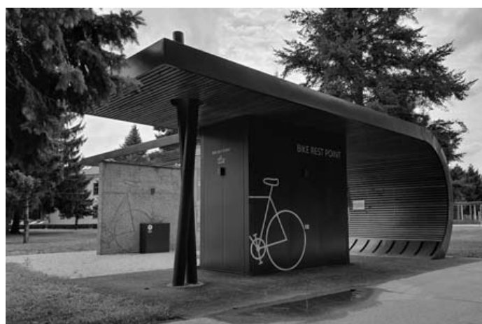
Zajednički projekt sa Dorianom Šipošom - izgradnja Bike Rest Pointa vojarne u Čakovcu
